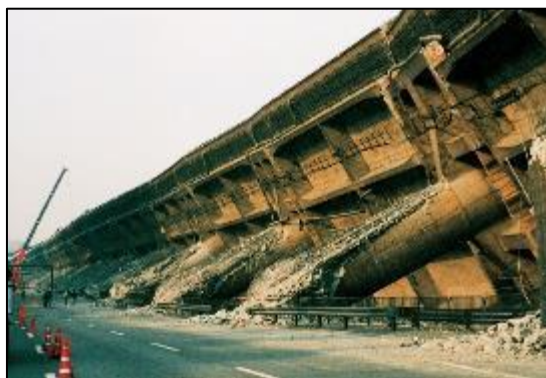
【兵庫県南部地震により倒壊した阪神高速】
